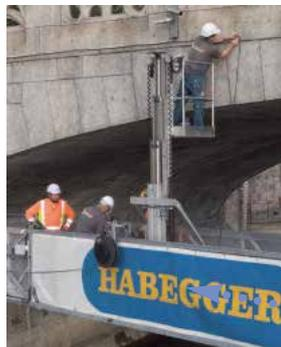
Der hydraulische Arbeitslift «Alplift» mit einer Standhöhe von 6 m kann im Telesteg frei bewegt werden.
