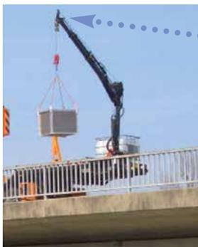
Der Hydraulikkran «Hiab» ermöglicht das Heben von Zubehör, Werkzeugen und Material von der Brücke auf die Plattform.
